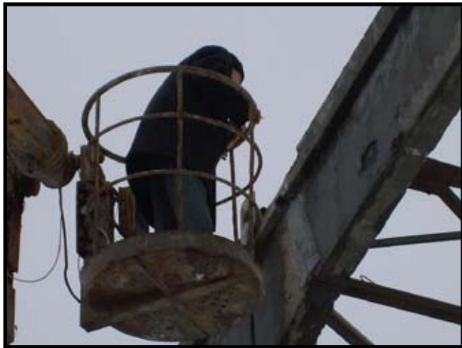
Фото 10. Осмотр карнизного угла для определения величины раскрытия трещин
