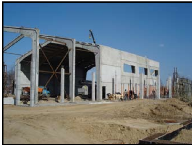
Фото 18. Смонтированные сборные ж/б панели стен
