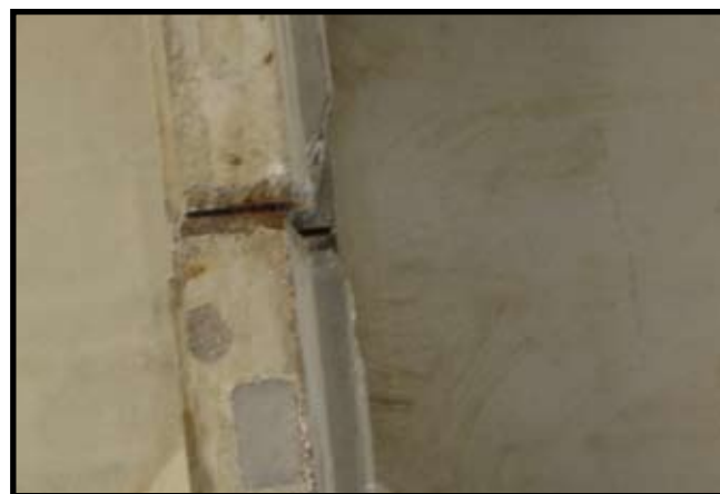
Фото 19. Стык элемента удлинения ригеля с Г – образным элементом
