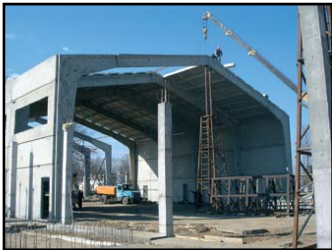
Фото 15. Здание в процессе монтажа
