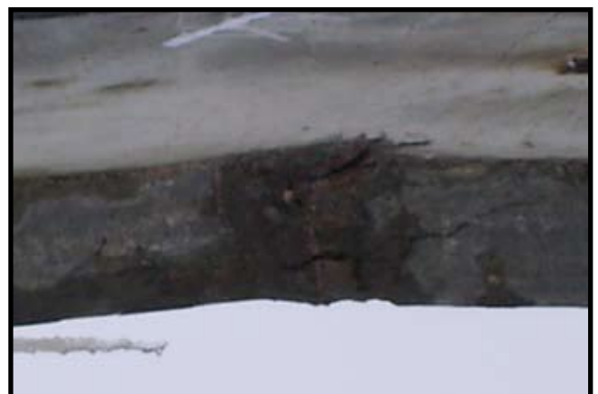
Фото 14. Продольные трещины в ригеле
