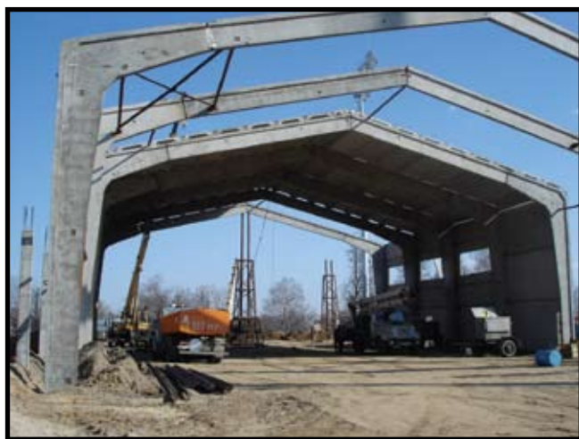
Фото 16. Смонтированные рамы здания
