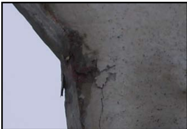
Фото 11. Смятие бетона в карнизном узле (внутренняя часть)
