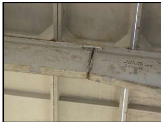
Фото 20. Фрагмент покрытий здания из ж/б ребристых плит в районе стыка
