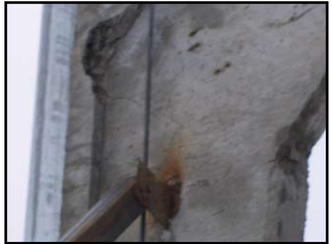
Фото 12. Откол бетона полки тавра в карнизном узле
