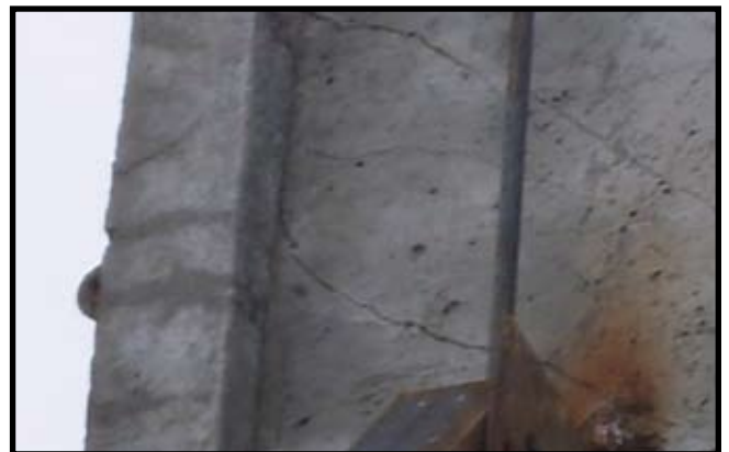
Фото 13. Поперечные трещины в стойке.
