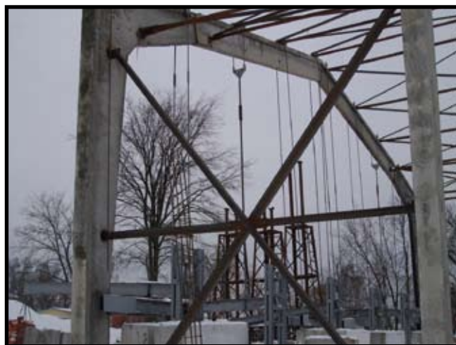
Фото 4. Вертикальные и горизонтальные диагональные стальные связи для обеспечения жесткости фрагменты
