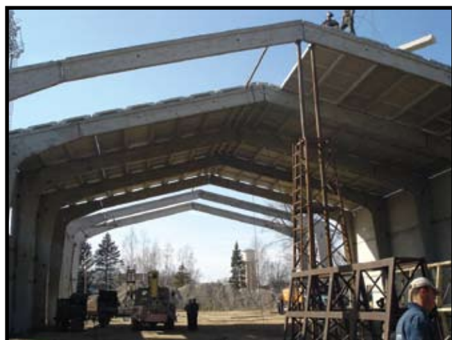
Фото 17. Монтаж плит покрытия
