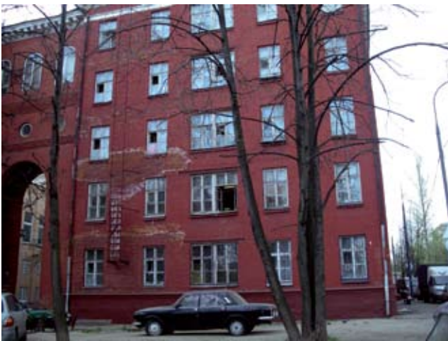
Причина под землей — последствия под крышей (рисунок 13).
