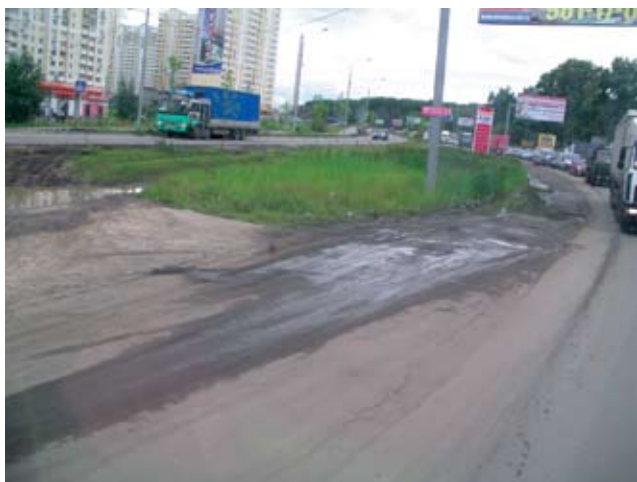
Обширное подтапливание дорожного полотна (рисунок 5).
