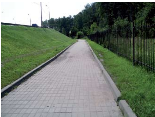
Пешеходные дорожки уже начали проседать и разрушаться. Под дорогой и развязкой тоже происходят эти же процессы (рисунок 9).
