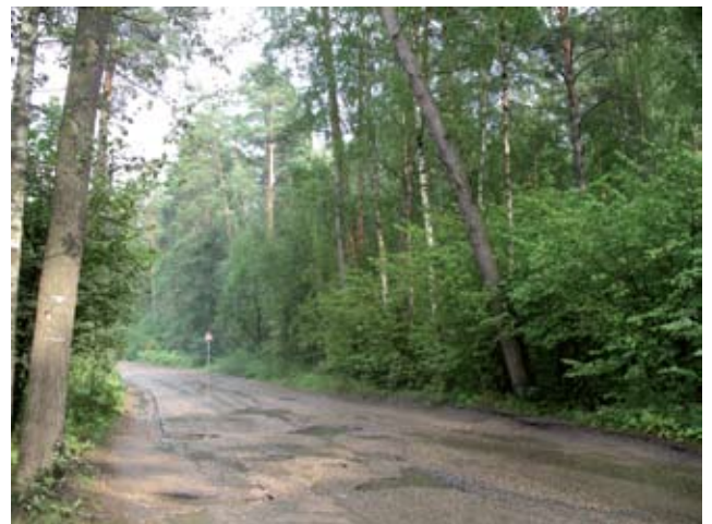
Разрушение дороги за счет просадок грунтов. Поднимающаяся вода «вывешивает» корни деревьев, провоцируя их наклон (рисунок 7).
