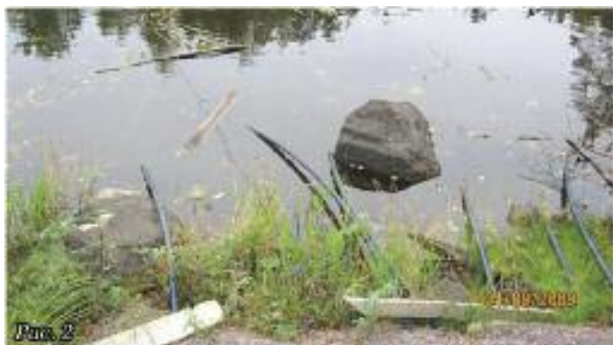
Рис. 2 Выходные ПНД-трубы первичного контура теплового насоса, уложенные на дно непромерзающего водоема
