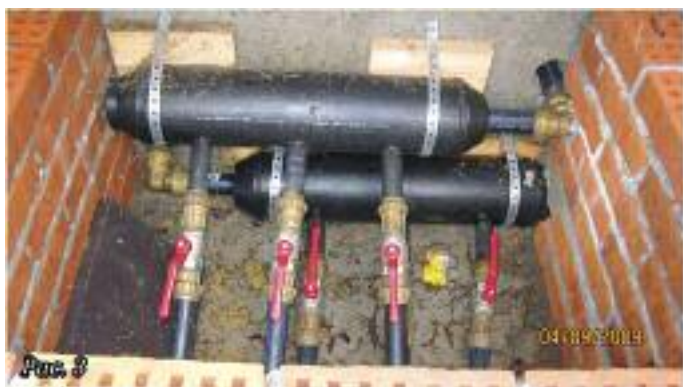
Рис. 3 Коллекторная группа первичного контура теплового насоса
