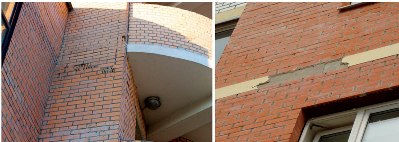
Рис. 2. Разрушение фасадов зданий со слоистыми стенами и облицовкой кирпичом
