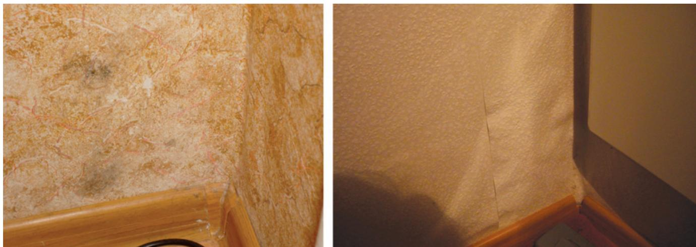
Рис. 4. Образование плесени и отслоение обоев из-за промерзания стен в зоне «мостиков холода» — в узле сопряжения наружной стены с междуэтажным перекрытием
